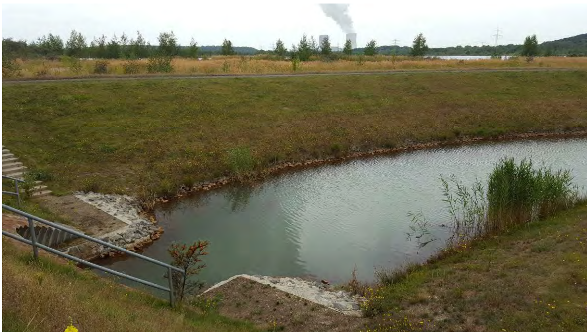
Abb. 3: Ableiter Hainer See, Kreuzungsbauwerk am Gewässerabschnitt vom Hainer See in die Pleiße mit Wirtschaftsweg 09.08.2016
