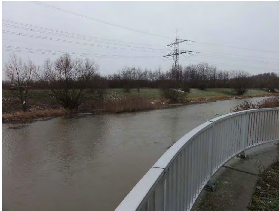
Abb. 15: Blick auf den Standort der geplanten Ausleitung des Zuleiters zum Kahnsdorfer See von der Pleiße 13.01.2017
