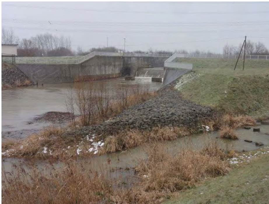
Abb. 12: Trachenauer Wehr, Blick von unterstrom, im Vordergrund Ausleitungsstrecke der Fischeufstiegsanlage 13.01.2017
