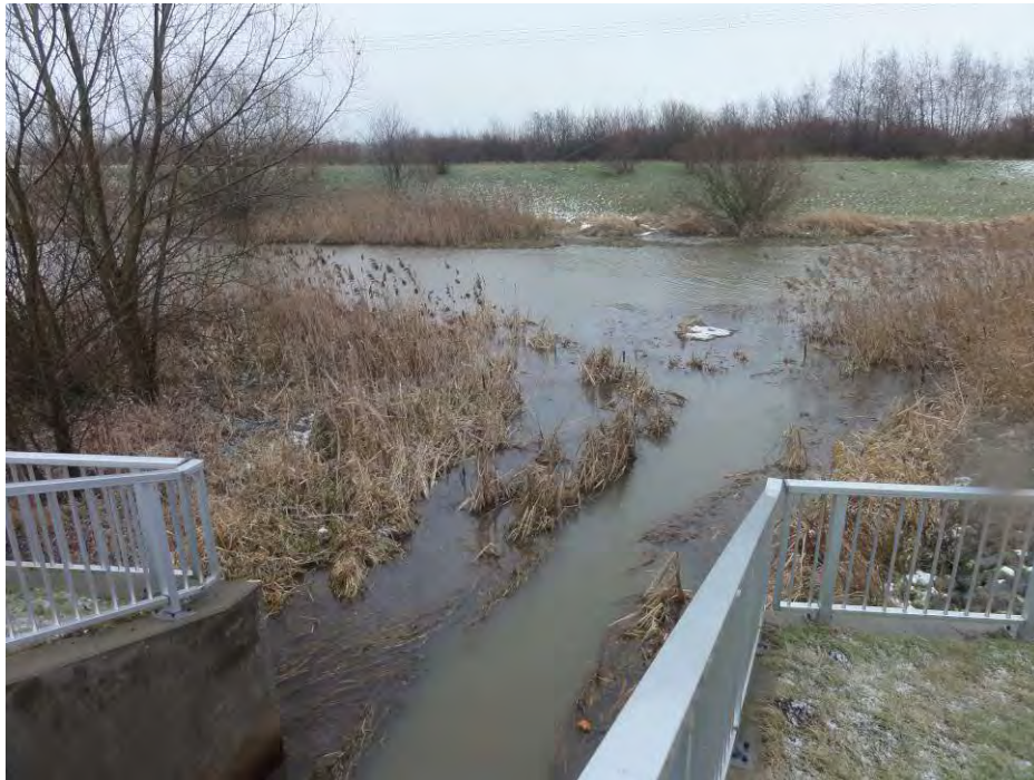
Abb. 13: Fischaufstiegsanlage am Trachenauer Wehr, Einlaufbereich 13.01.2017
