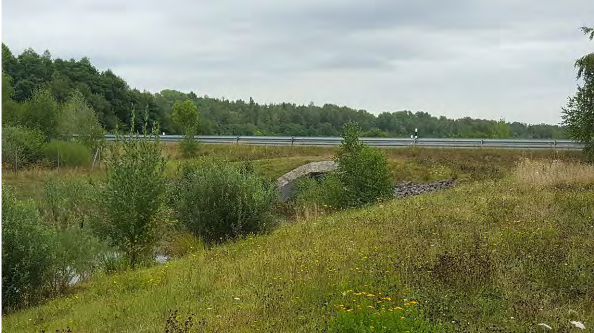
Abb. 5: Brückenbauwerk/Durchlass Querung Gewässerabschnitt vom Hainer See in die Pleiße mit der Kreisstraße K 7930 09.08.2016
