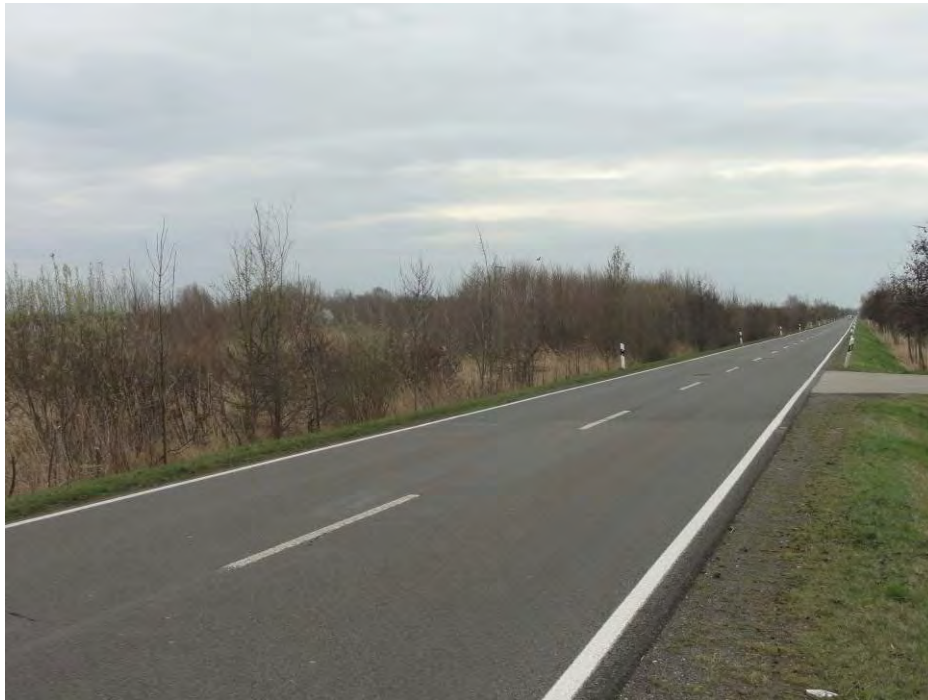
Abb. 17: Kreisstraße K 7930, Bereich geplantes Brückenbauwerk/Durchlass Querung Gewässerabschnitt vom Hainer See in die Pleiße mit der Kreisstraße K 7930 29.03.2017
