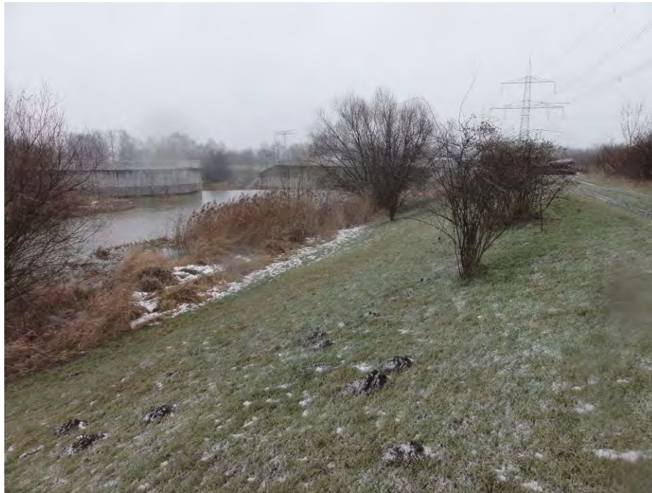
Abb. 11: Standort der geplanten Ausleitung des Zuleiters zum Kahnsdorfer See von der Pleiße 13.01.2017
